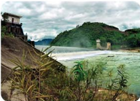
Hình 7.8. Công trình đầu mối thuỷ lợi Thạch Nham (xã Nghĩa Lâm, huyện Tư Nghĩa)
