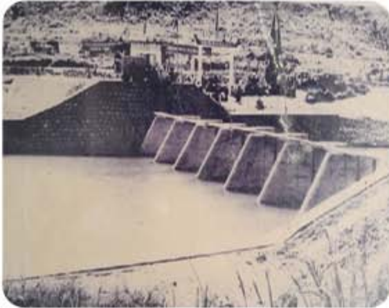
Hình 7.6. Đập 19/5 khởi công xây dựng ngày 24/6/1975 (huyện Tư Nghĩa)
